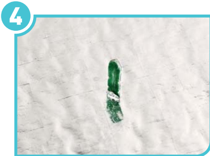
İzolasyon malzemesi folyosu dışa gelecek şekilde PRATİK PİM'e saplanır.
