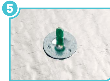
Yuvarlak plaka PRATİK PİM'in diline geçirilir. İstenirse sağa ya da sola çevrilerek kilitlenir.
